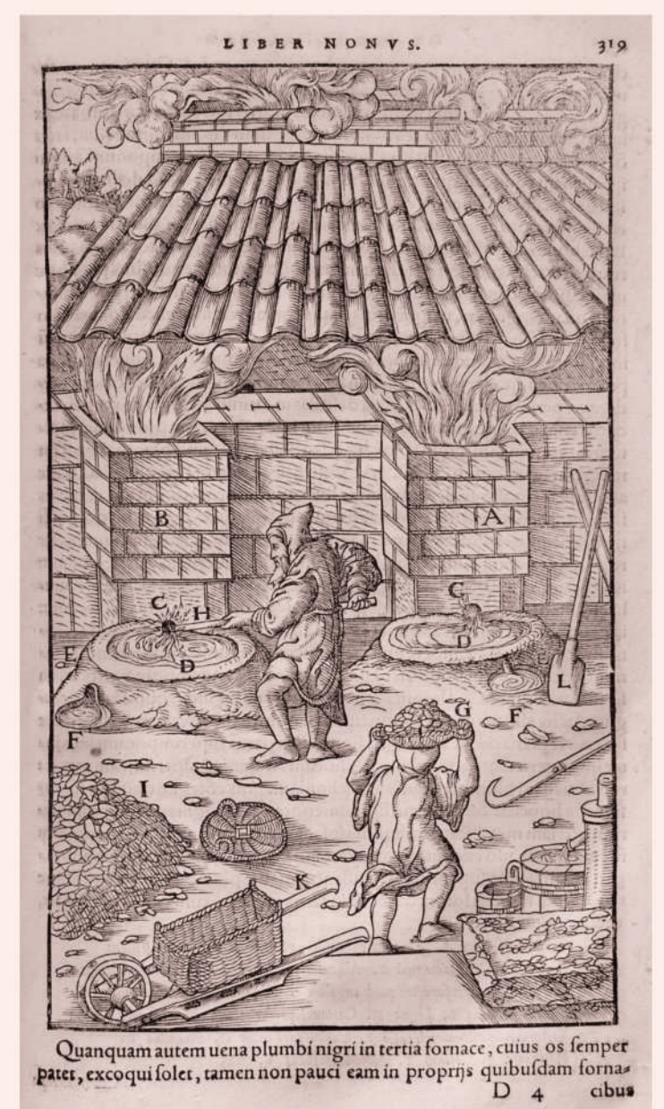
Tavba rud ve vyobrazení v díle Georga Agricoli De re metallica.
